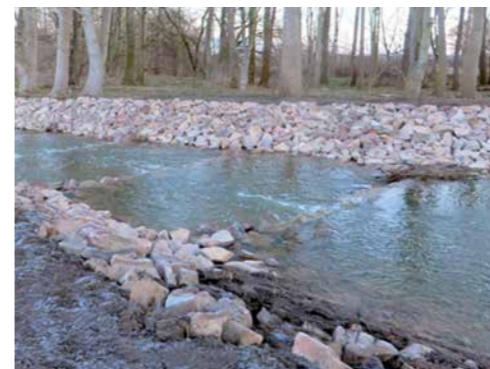
Mit einer Fischtreppe und weiteren Maßnahmen verbesserten wir die Wasserversorgung der Haselbacher Teiche – Heimat für Zwergdommel (o.) und Co.
