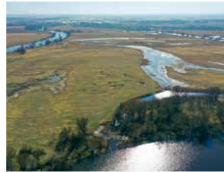
Fertiggestellte Flutrinne an der Havel
