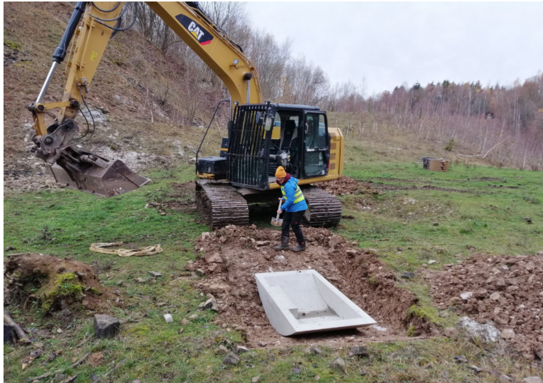
Betonbecken mit Versteck für die Gelbbauchunke
